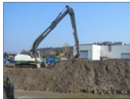
Arbete med filterkonstruktion utanför Brandts. Foto: Annelie Loberg
