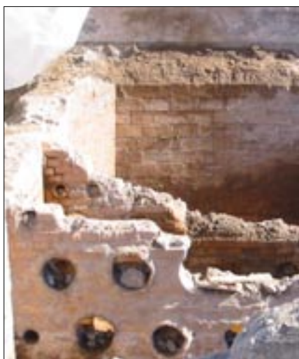
Under bottenplattan på gamla EKA-fabriken fanns denna grundkonstruktion. Den gamla husgrunden har fyllts igen med ny jord. Foto: Annelie Loberg
