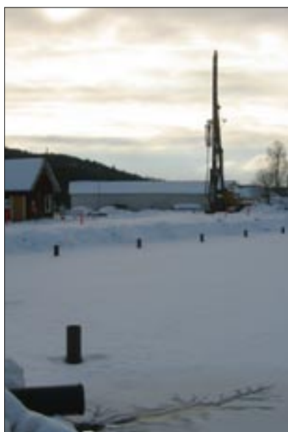
Plintar för bryggan har anlagts längs med strandkanten vid sjöboden. Foto: Annelie Loberg
